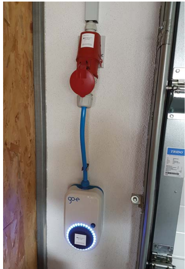
Abbildung 17: Betriebsbereite portable Wallbox in diskreter Wandhalterung
